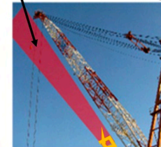
JR東日本工事現場
