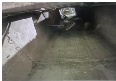
附照1 災發當時吊掛手推車情況(停於地下1、2樓之間)
