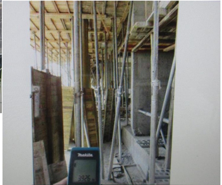
D 至 E 範圍下層可調式鋼管支柱為模板支撐(高度約 3.9 公尺)
