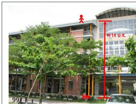
照片 1 災害發生於○○縣○○鄉○○國民小學行政大樓建築物外。
