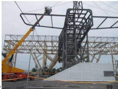
罹災者災害當時作業為飛機尾翼左側上方之2根斜拉桿之除銹油漆工作
