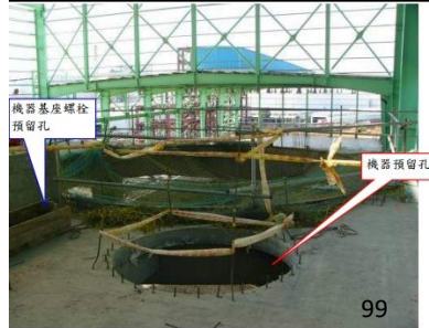
附照 1、災害發生處，機器預留孔(墜落處，直徑 180 cm)四週原留有 4 支高約 60 公分之鋼筋，並纏繞黃色警示帶。
