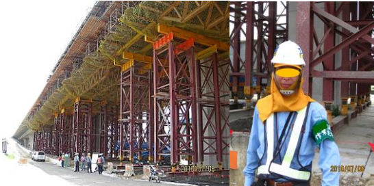
模板支撐組配、拆除應指派作業主管在場指揮監督
