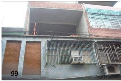
捲揚機於3樓位置
