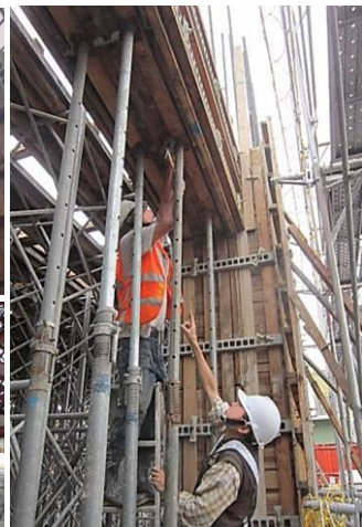
模板支撐組配、拆除應指派作業主管在場指揮監督
