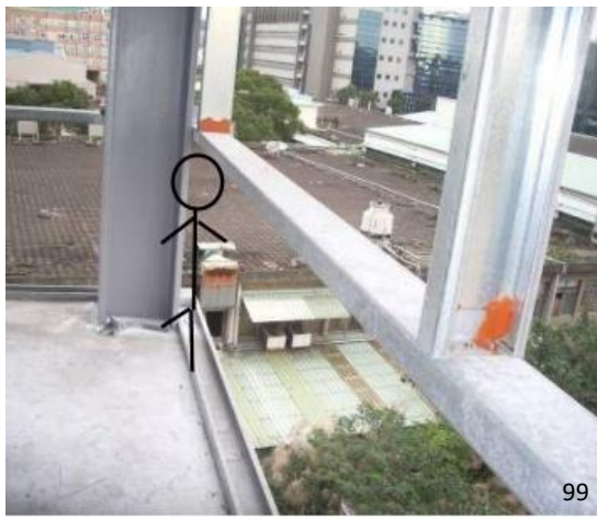
許○○於 2 樓頂板作業位置
