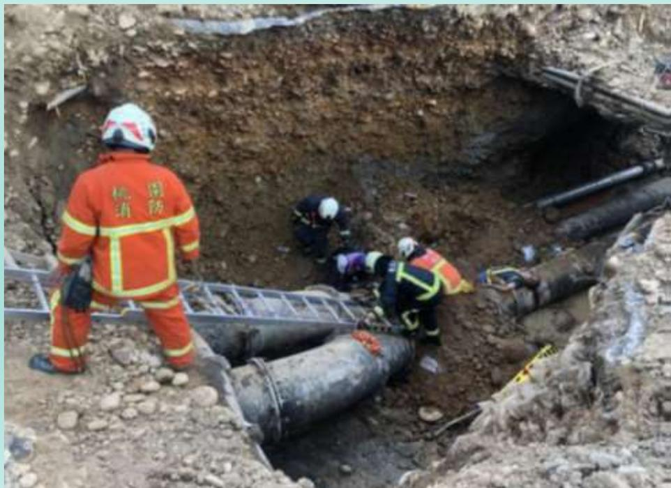
事故發生前施作人員共7人配合一台PC200挖溝機於現場進行管溝露天開挖及接管作業，其中O工程有限公司5名勞工於露天開挖坑內作業，於下午16時40分許管線接管作業完成，正準備收拾工具撤離時南側之開挖坡面突然發生坍塌，其中勞工陳00已上至地面未受傷、另許00挫傷自行爬出、黃00遭滑落的土石砸傷，朱00及陳00等2名勞工則下半身遭崩落土石掩埋。O工程建設股份有限公司工程師許00在開挖面上方發現土石崩落，立即於16時50分通報119，並於17時許通報監造單位及工務所，於17時8分許救護車抵達後將傷者送醫後死亡。
