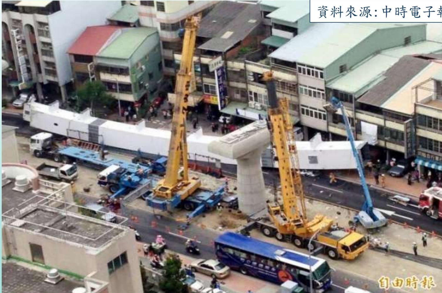
104. 4. 10. 於臺中市北屯路和文心路口處，16時許正在進行吊梁工程，16時58分重達209噸的鋼梁掉落，造成底下的兩部車輛被壓毀，4人死亡、4人受傷。因吊車外伸撐座未鋪設木板分散壓力，導致柏油路面無法承受吊車壓力而凹陷的結果，另未使用螺絲假固定或確實鎖妥，就鬆開吊車支撐，曲線路段使得鋼梁重心向中間偏移，導致鋼梁外翻掉落地面。
