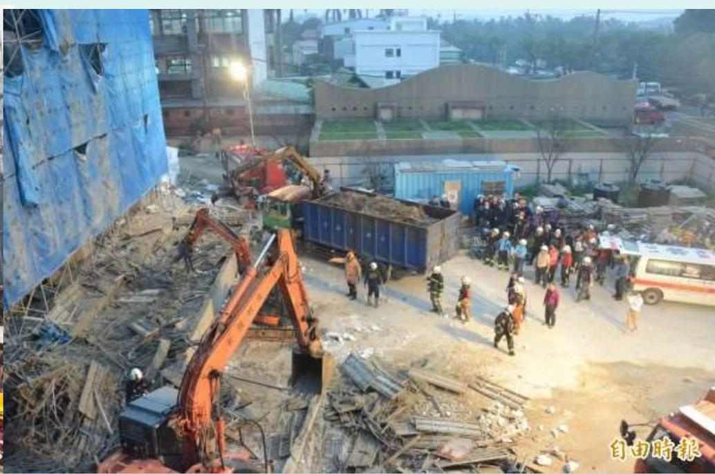
大溪高中新建圖資大樓工程，105.12.21下午進行5樓頂女兒牆綁紮工程、灌漿作業快完成時，女兒牆卻突然倒塌，並拉扯工地建築外的鷹架，當時在鷹架上工作的5名工人，全都從高樓摔落，並遭到未乾的泥漿與鷹架掩埋致死。
