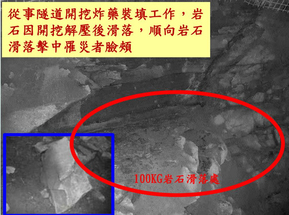
陡坡鬆動之破碎岩盤掉落
