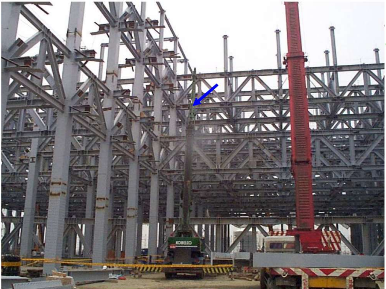
鋼構吊裝工程(箭頭為罹災者作業位置)
