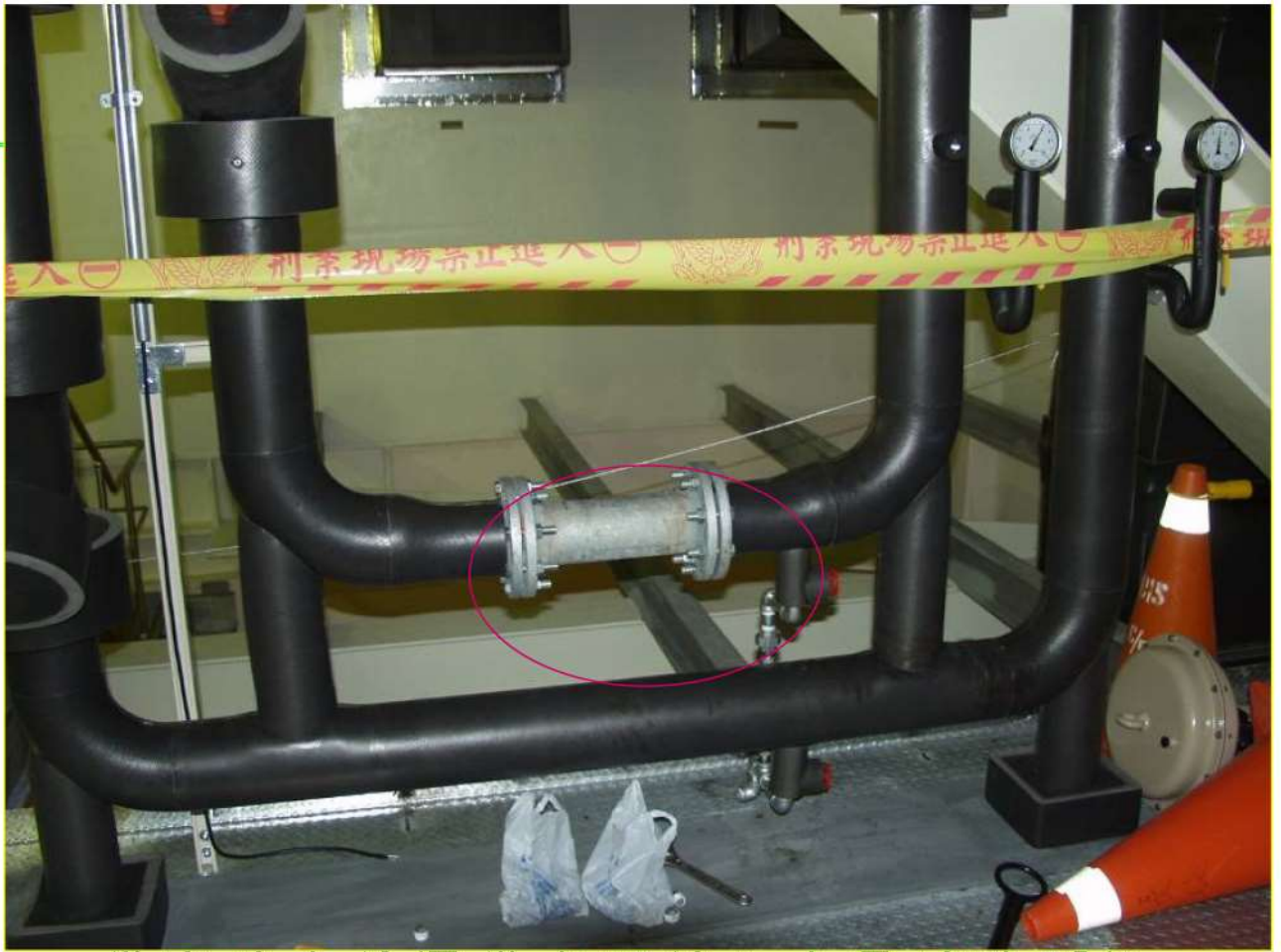
災害發生前罹災者固鎖之水壓試驗螺栓
