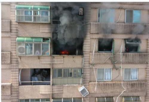
新竹縣竹北市24日上午瓦斯加壓站壓力異常，造成市區多處住宅瓦斯外洩，1大樓氣爆。新竹縣消防局提供
