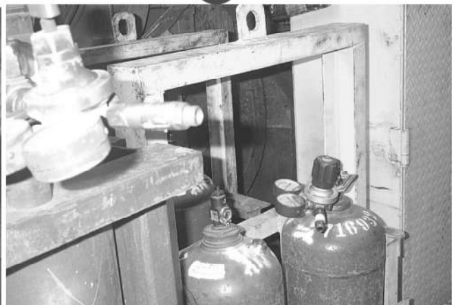
裝設防逆火裝置
