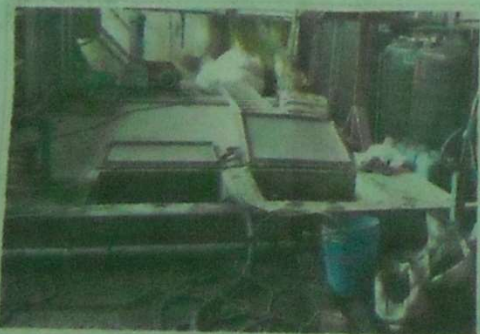
盈發皮革廠地下污水槽(圖)沼氣導致6名工人喪命。資料照片
