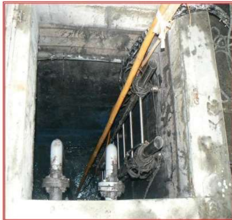
調整池內部概況
