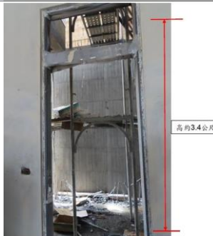
外牆施工架第2層工作臺，高度約3.4公尺
