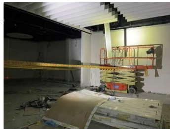
照片：罹災者站立於高空工作車之欄杆上從事切割作業，因重心不穩而墜落。
