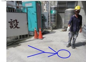
說明一 災害發生於本工程之1樓室外地面處。
