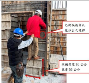
災害發生時，罹災者於地面上放置一塊模板斜靠在已組好之電梯牆模板上，站上該斜靠之模板上緣，並將右手伸進已組立好三塊電梯牆模板內，將放置於已綁紮好電梯牆鋼筋上之螺桿由第三塊模板穿孔處拉出。
