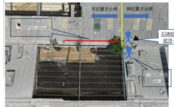
照片一 據目擊者謝○○所述，罹災者拆除石綿板後，將石綿板搬運至交由其收集，罹災者正在搬運石綿板，不知為何突然往底下沒有梁石綿板地方踏去，造成踏破石綿板墜落致死。
