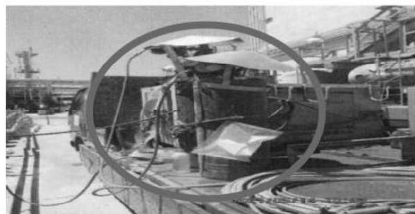
鋼瓶危害標示破損
