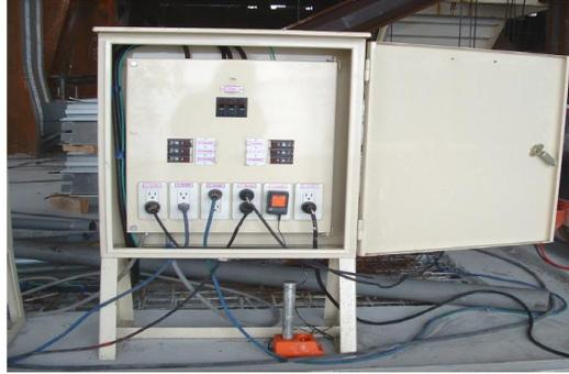
臨時用電所使用之配(分)電箱設置箱、蓋、中隔板等防止人員誤觸帶電部分。
