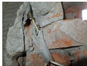
破碎機鑽頭打到壁面電壓110伏特之電源線。
