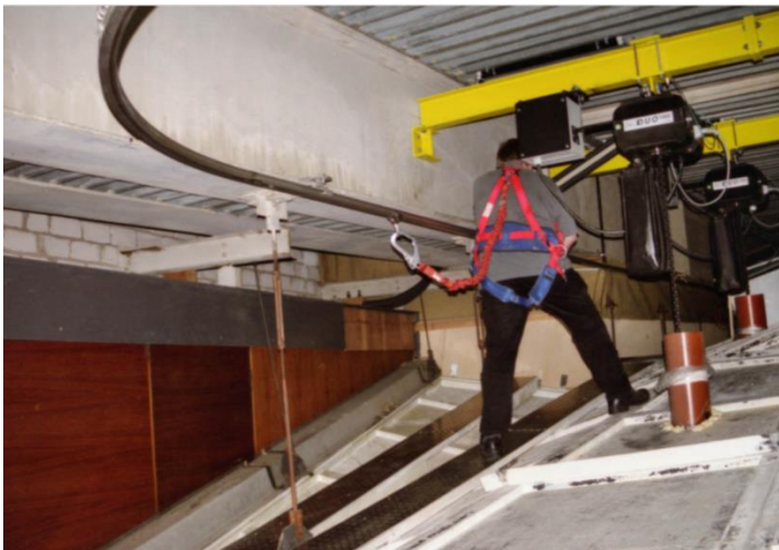
軌道式水平安全防墜系統
