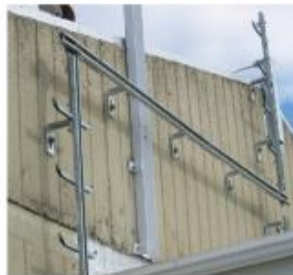
屋頂作業防墜系統轉軸向 (圖例安全帶未離身)
