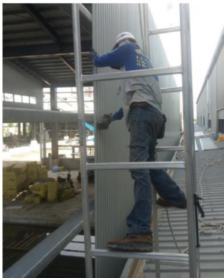
作業人員使用管架進行外牆鎖固 作業
