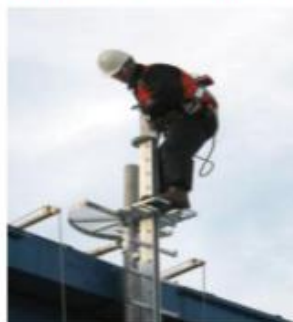
屋頂作業防墜系統轉軸向 (圖例安全帶未離身)
