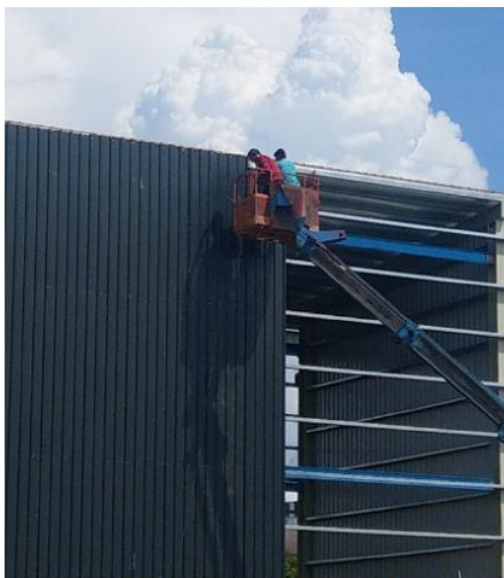
浪板上端校正後先予以固定
