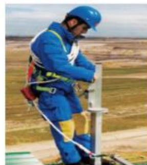
屋頂作業防墜系統轉軸向 (圖例安全帶未離身)
