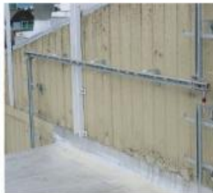
屋頂作業防墜系統轉軸向 (圖例安全帶未離身)
