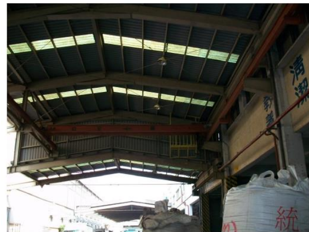
在採光罩下方安裝防墜系統
