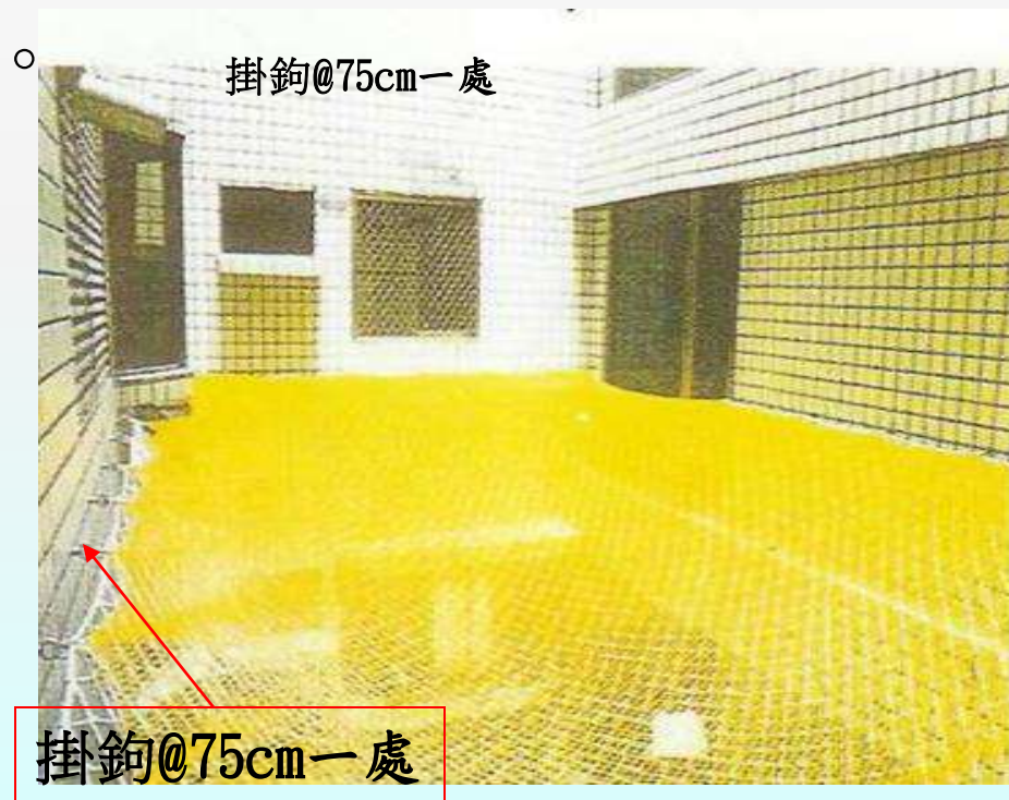
圖 覆網、安全網設置例
