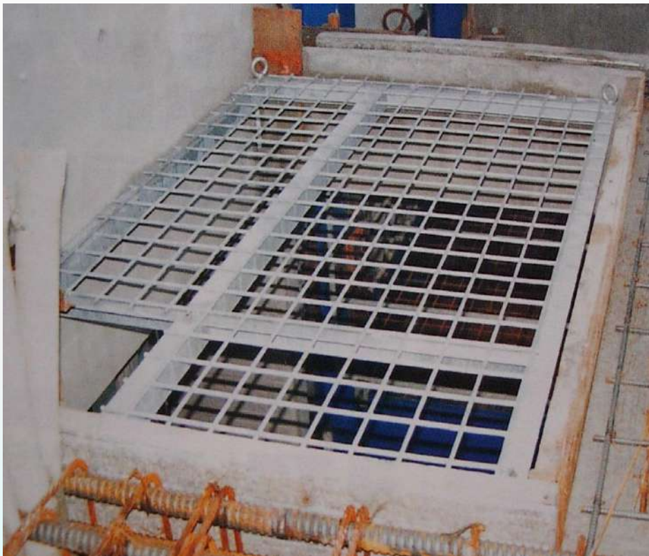
圖3-5 護蓋應具適當之強度表面塗刷黃色油漆並書以警告訊息
