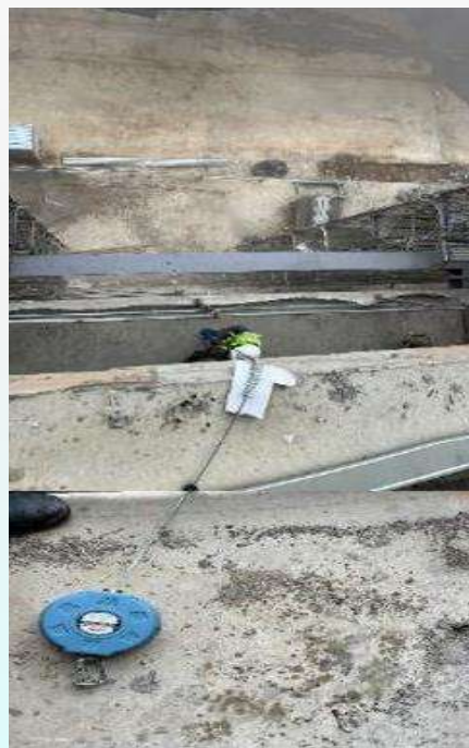
已經調整捲揚式防墜器固定點高度
