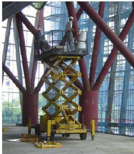
圖 2-8 高空工作車作業勞工未佩戴安全帶並從事供為主要用途以外之作業
