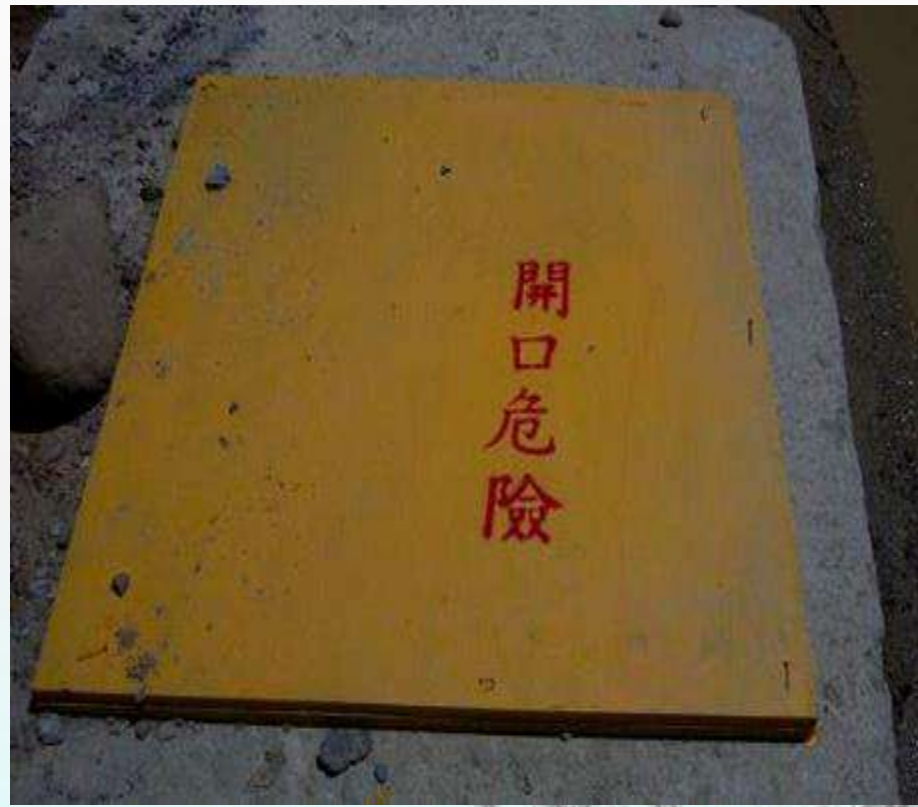
圖3-5 護蓋應具適當之強度表面塗刷黃色油漆並書以警告訊息
