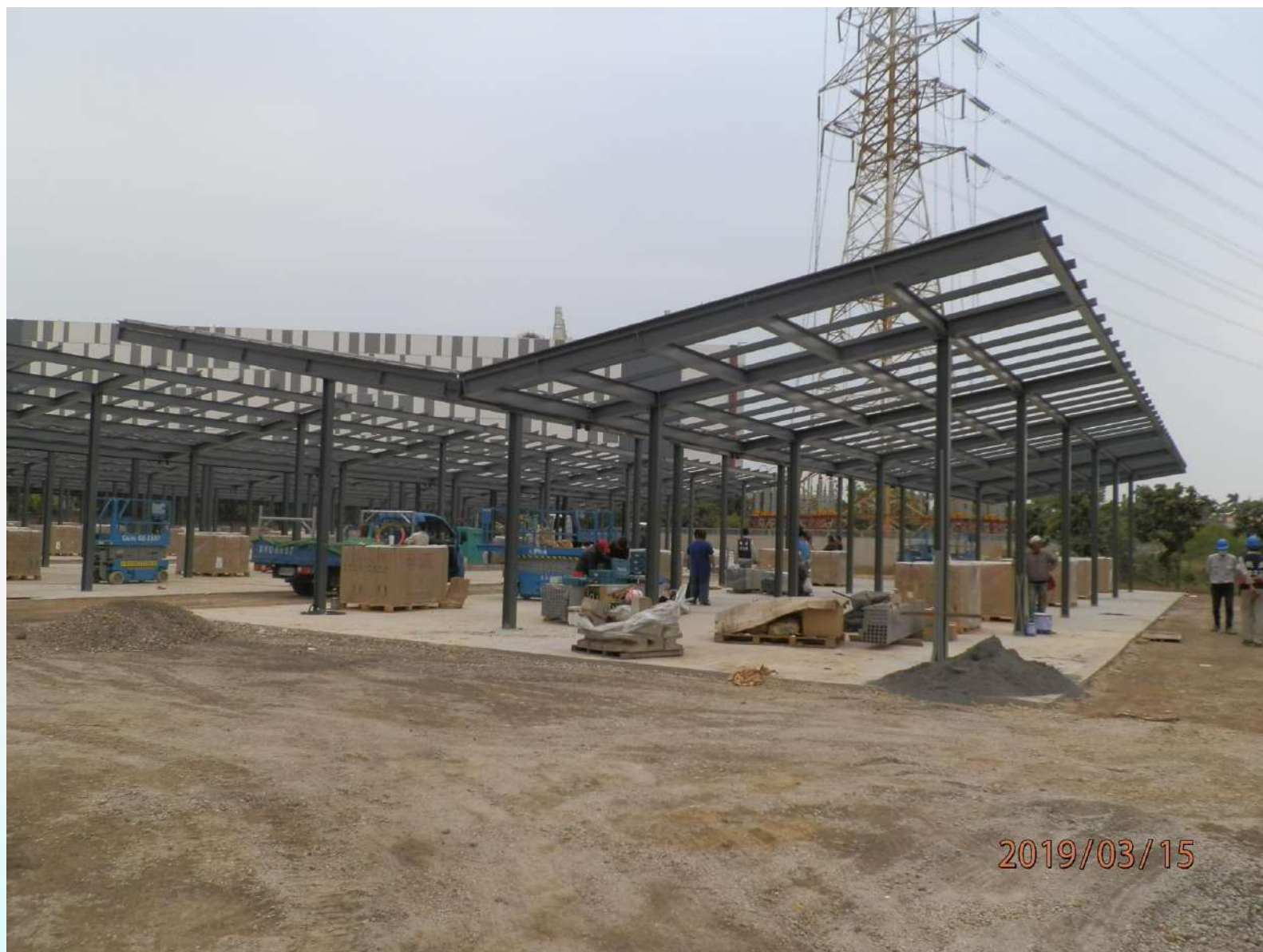
台積電停車場太陽能板施工
