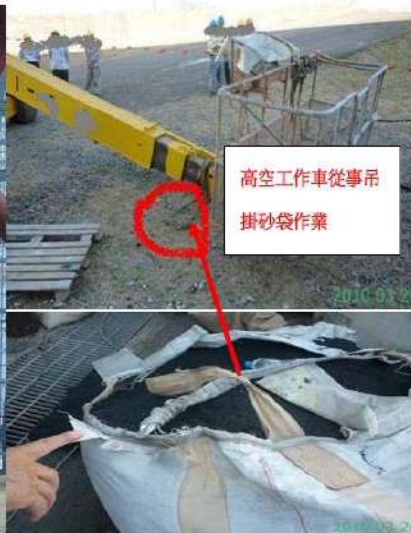
圖 2-8 高空工作車作業勞工未佩戴安全帶並從事供為主要用途以外之作業
