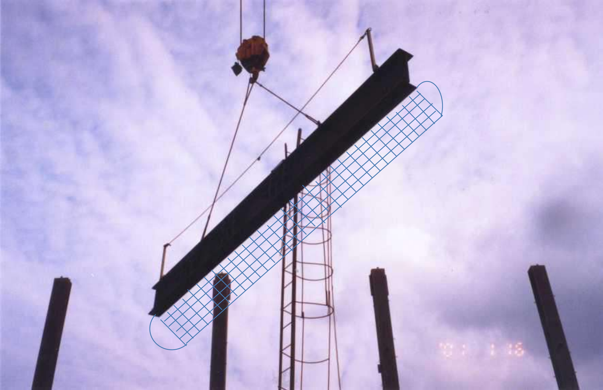
鋼樑上預裝杆柱、安全網、安全母索與臨時護籠鐵爬梯
