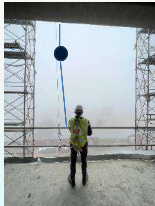
已經調整捲揚式防墜器固定點高度
