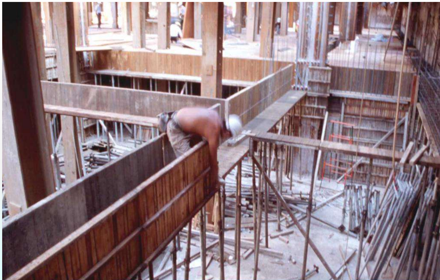
樓版及柱樑底模組立
