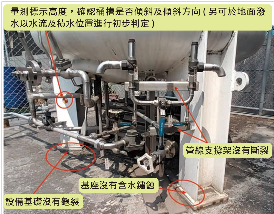
圖 40 設備基礎檢點
