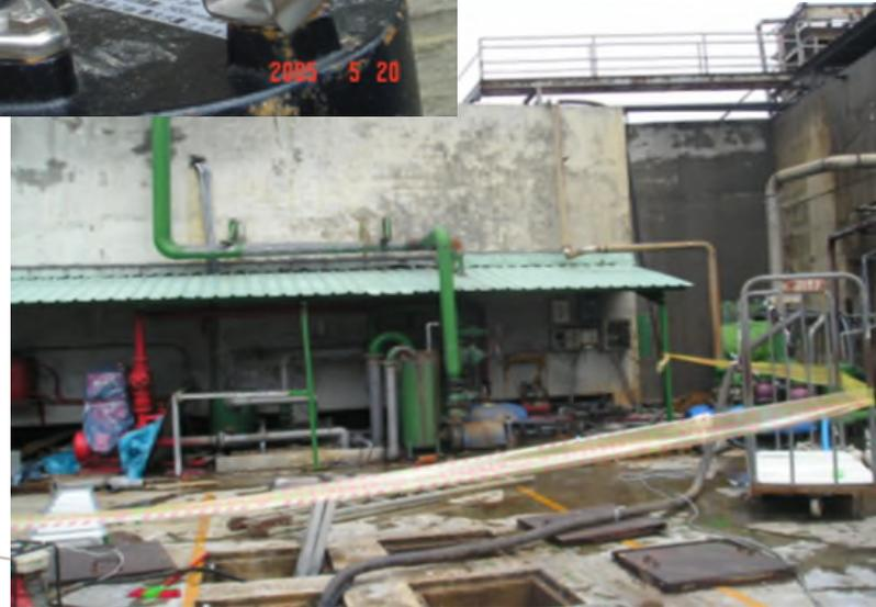
7名勞工一起進入蓄水池作業，不久在鋁梯旁操作沉水泵浦的宋勞工突然被沈水泵浦電到，在旁的崇勞工亦倒在鋁梯旁，陳勞工試圖攀登鋁梯逃生，亦被電擊倒下，江勞工試圖用掃帚將電源線與鋁梯分離，但他似已感電腿軟。其他人合力拉江勞工遠離沉水泵浦，接著某勞工投擲鏟子撞擊鋁梯，使鋁梯與電源線分離，於是其他人爬上鋁梯逃生成功，隨即將陳、宋、崇及江送醫急救。
