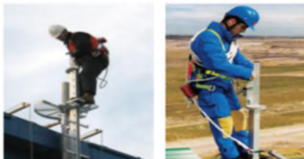
屋頂作業防墜系統轉軸向 (圖例安全帶未離身)
