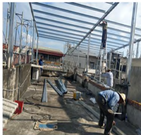
以鏽蝕施工架作為上下設備且無工作轉台
