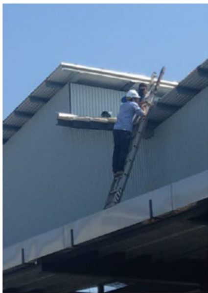
以移動梯作為上下設備
