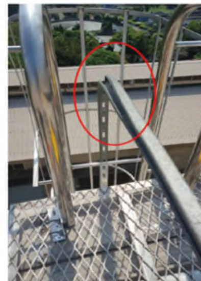
X軸 (水平向) 或 Y軸 (垂直向) 擒墜器無障礙通行
