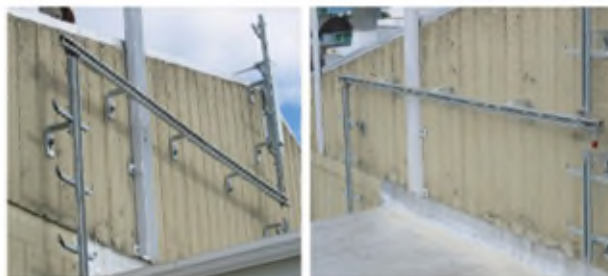
屋頂作業防墜系統轉軸向 (圖例安全帶未離身)
