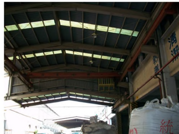
在採光罩下方安裝防墜系統
