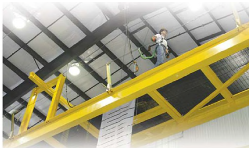
安全通道設置防墜系統並和主體結構連結
