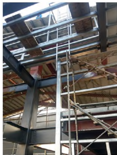
以鏽蝕施工架作為上下設備且無工作轉台
