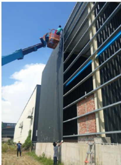
浪板上端先做假組裝，在地面的作業人員進行校正
