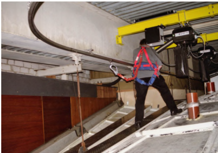
軌道式水平安全防墜系統
