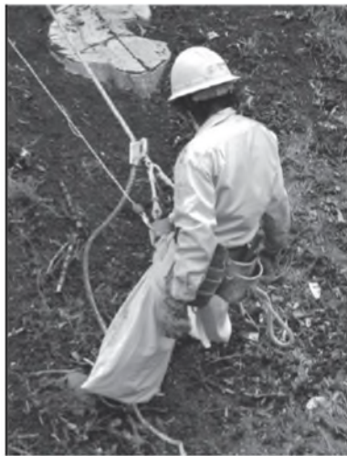
屋頂、斜坡長時間工作使用雙索作業
