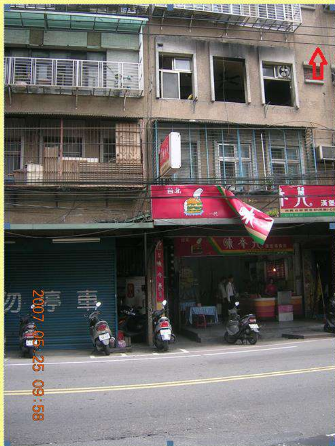
罹災者自距地面約7公尺高處之3樓墜落地面。
