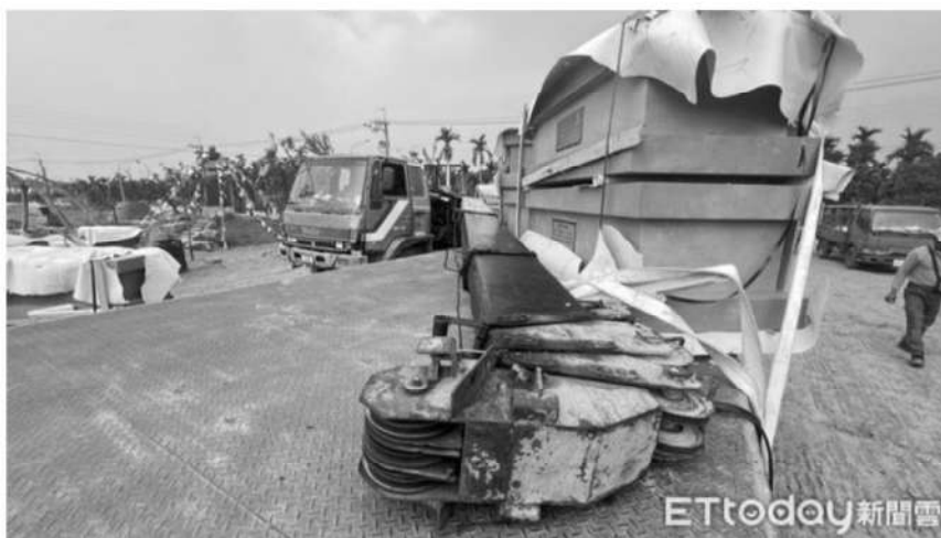
▲屏東工人操控吊車時，吊臂突然掉落砸死他。(圖／民眾提供，下同)
