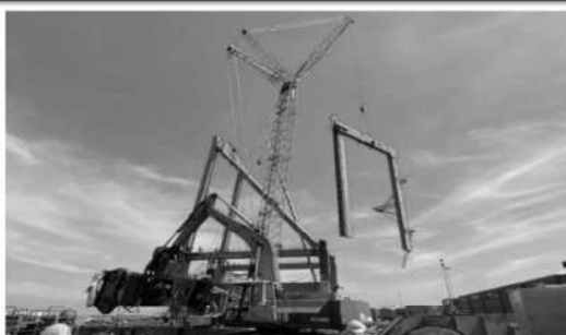
履帶起重機將門型吊舉物吊起情形
