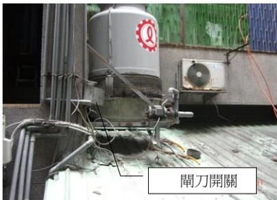
冷卻水塔，左側閘刀開關，及下方鐵架均帶電。
