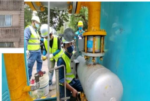
新竹瓦斯公司中正國小整壓站軸流閥故障引起竹北氣爆，新竹縣政府事後檢視全縣瓦斯管線設備，並預防性更換全縣18個閥流閥。新竹縣政府提供
