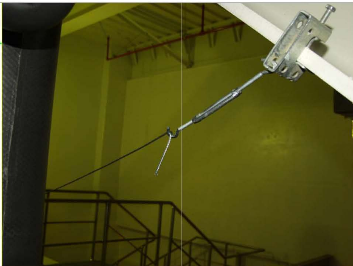
馬鞍環脫落後鋼線復原照片
