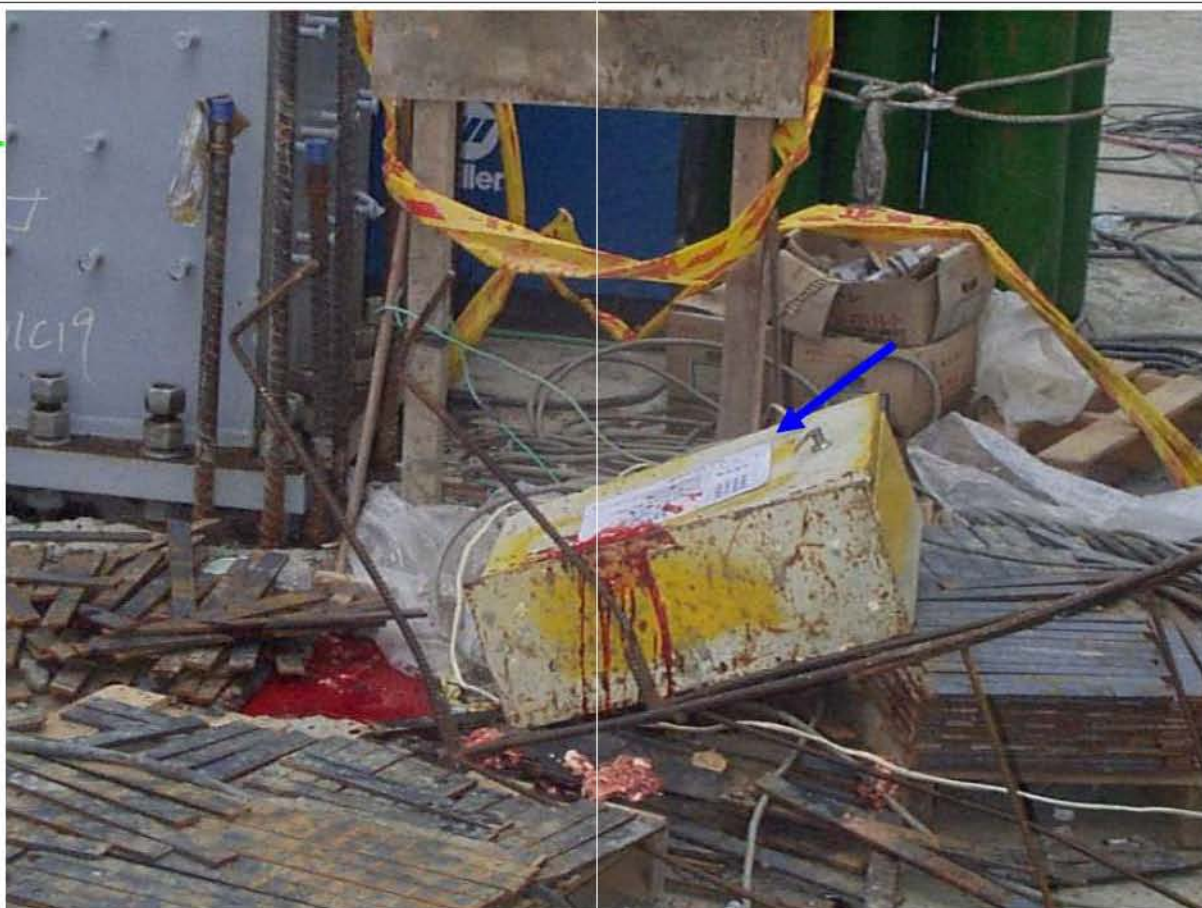
罹災者墜落頭部撞擊配電箱
