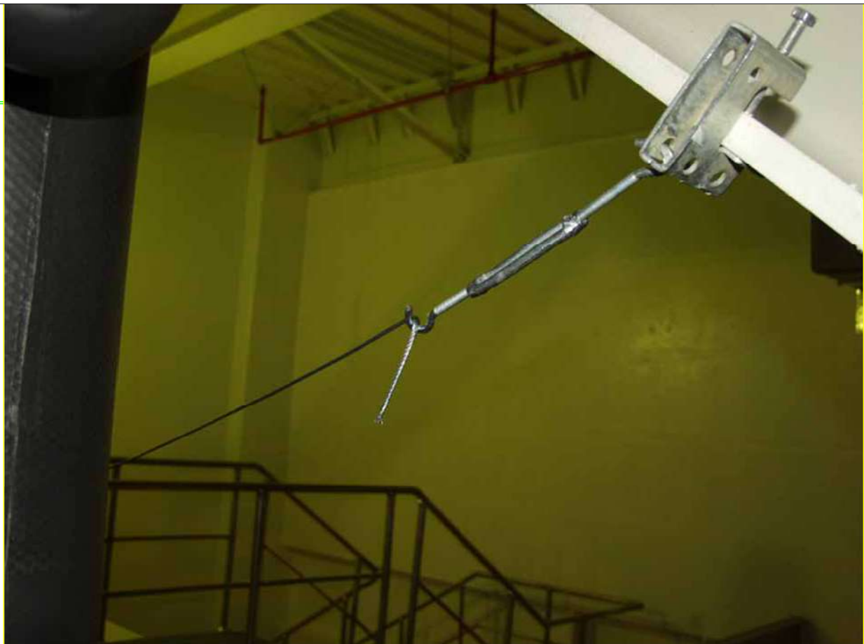
馬鞍環脫落後鋼線復原照片
