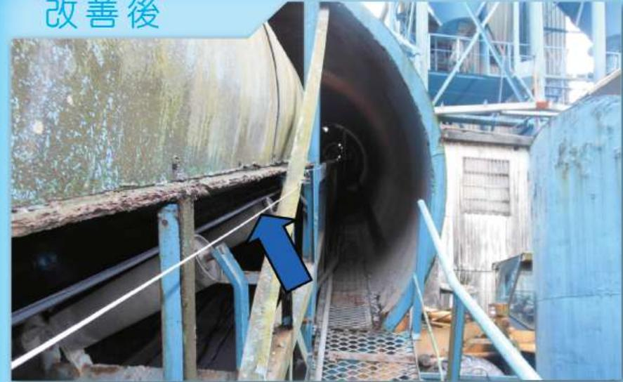
說明：輸送帶已設置緊急制動拉繩。
