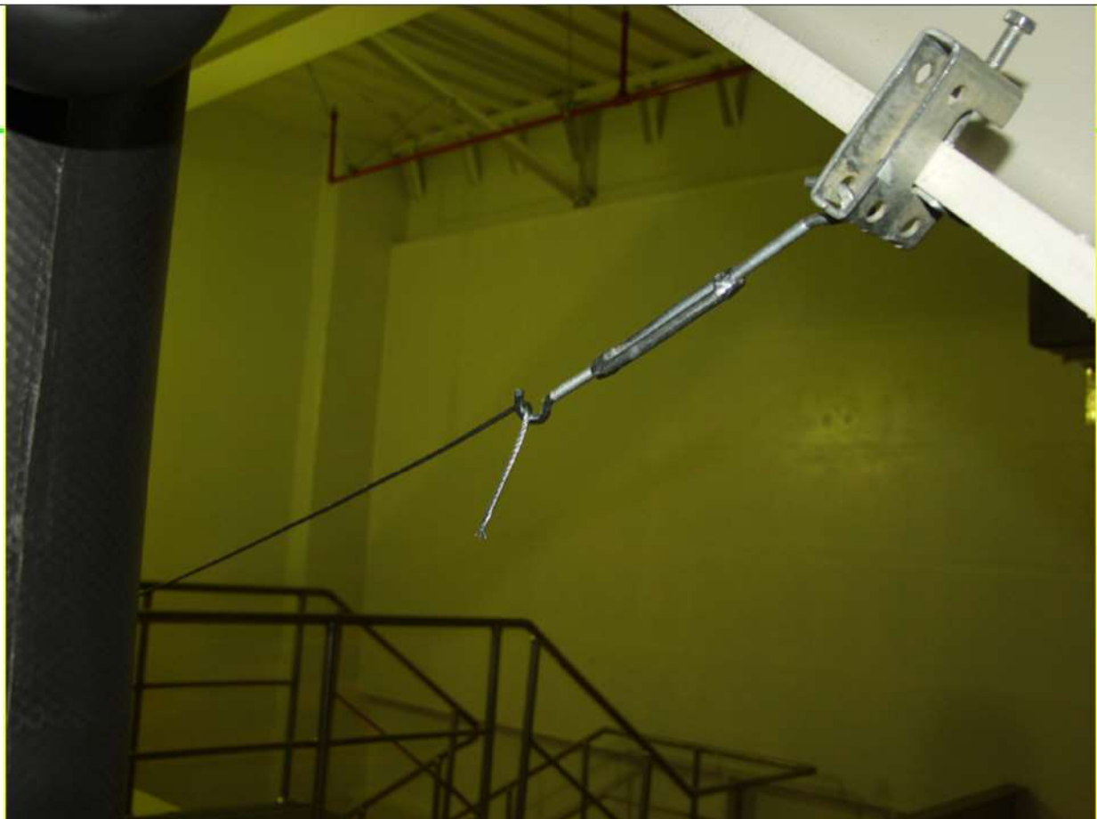
馬鞍環脫落後鋼線復原照片
