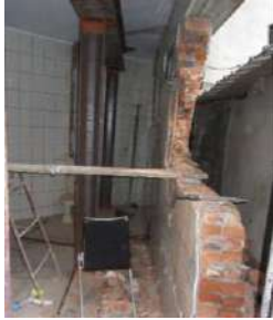
災害現場磚牆拆除作業所搭設簡易工作架
