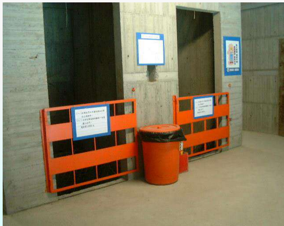
圖 護欄形狀應具上欄杆、中欄杆、腳趾版及杆柱、標示
