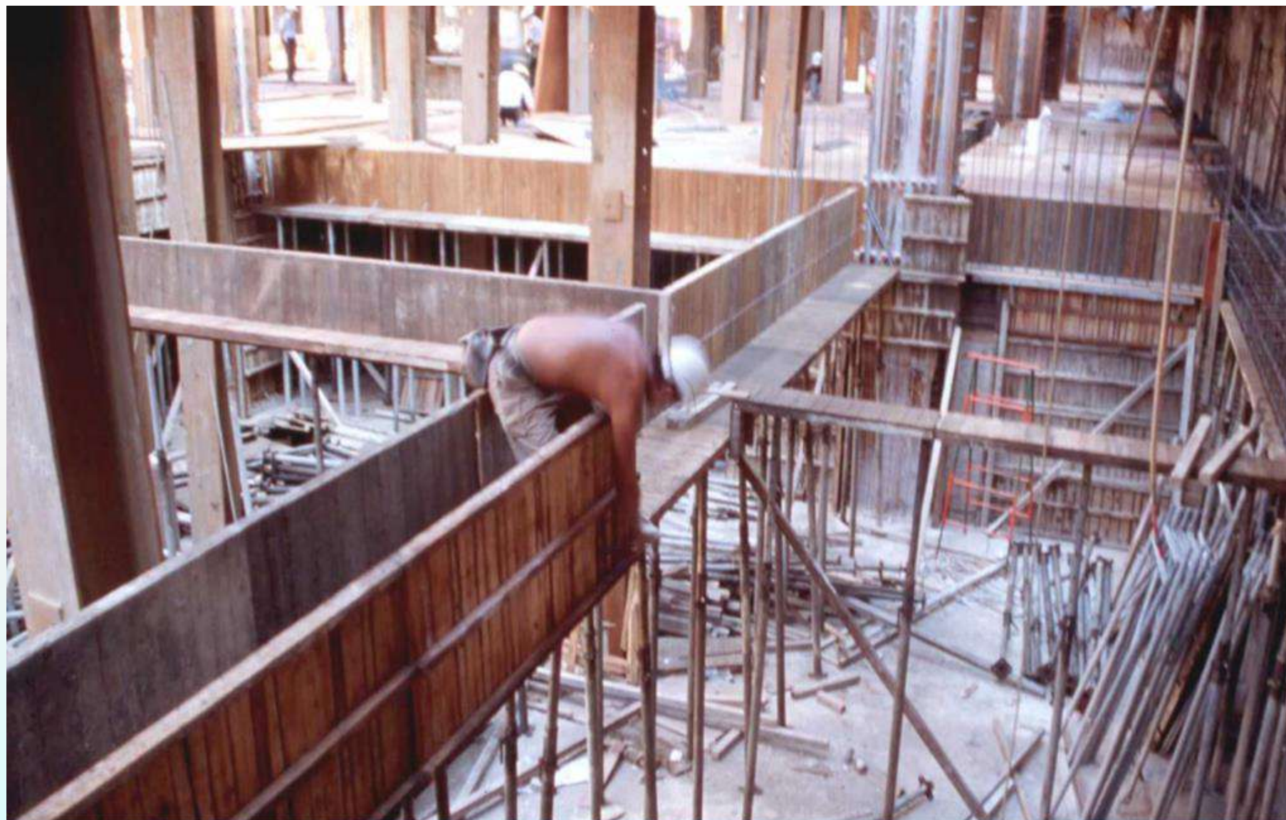
樓版及柱樑底模組立
