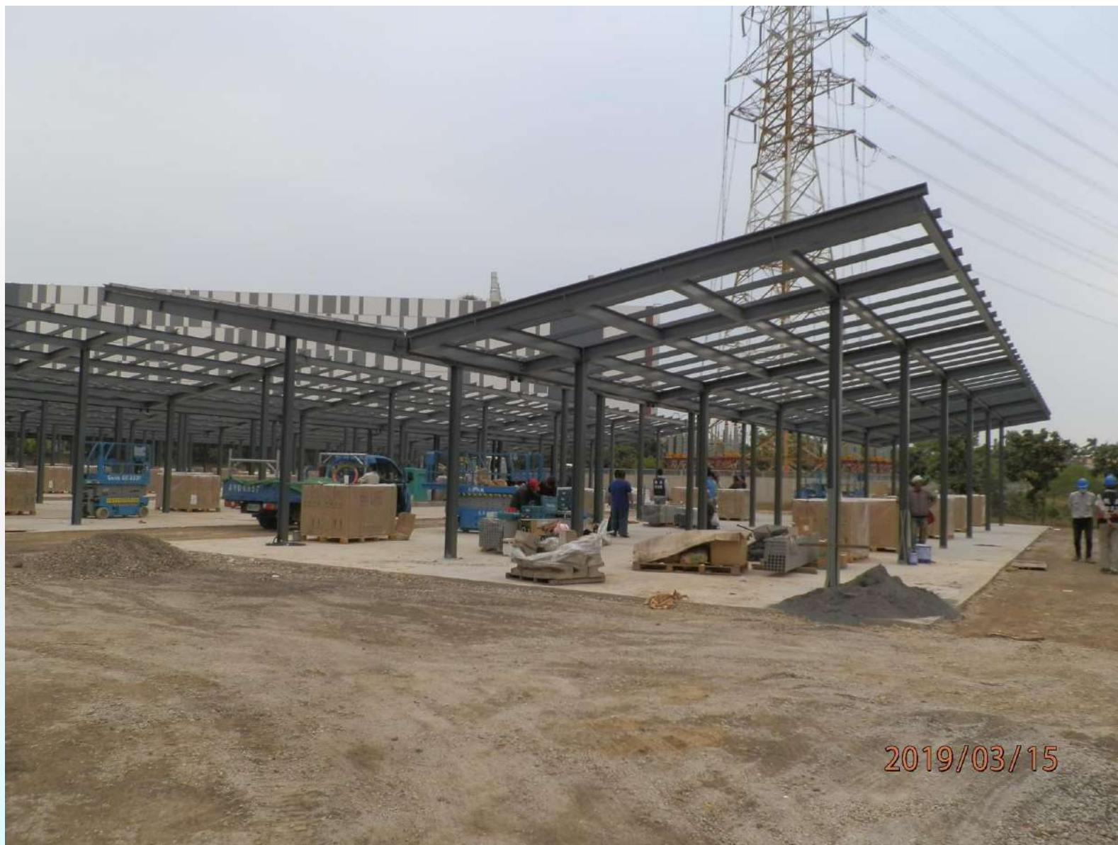
台積電停車場太陽能板施工
