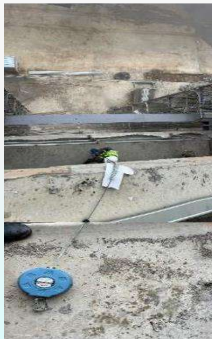
已經調整捲揚式防墜器固定點高度
