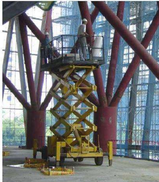
圖 2-8 高空工作車作業勞工未佩帶安全帶並從事供為主要用途以外之作業
