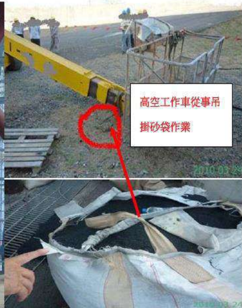
圖 2-8 高空工作車作業勞工未佩帶安全帶並從事供為主要用途以外之作業
