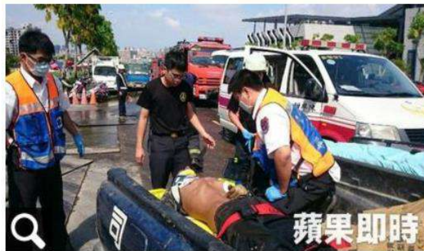
大立光位在精密園區的新建工程，下午發生工人從高處墜落意外。翻攝畫面
