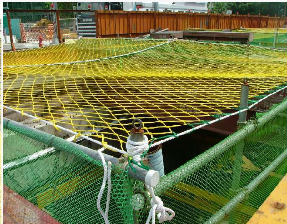
圖 覆網、安全網設置例
