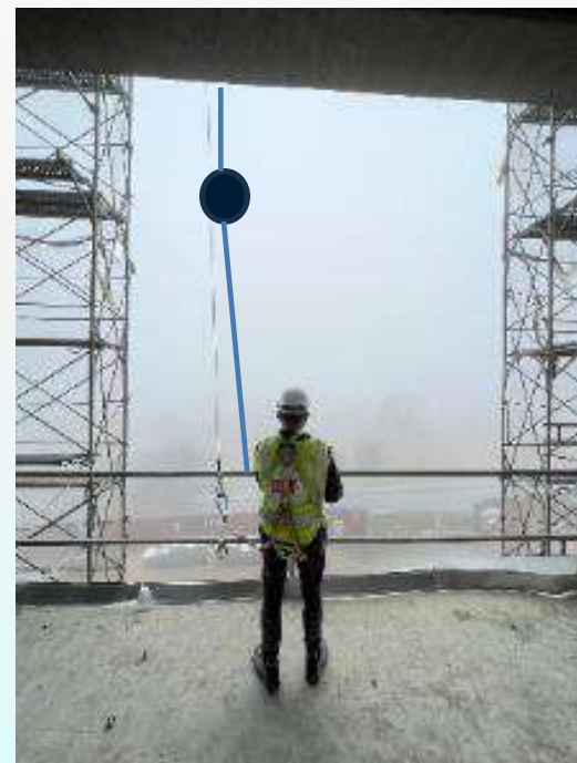
已經調整捲揚式防墜器固定點高度
