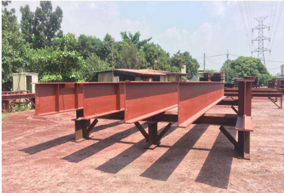
說明 鋼構上矽砂噴除作業中墜落，頭部撞擊鋼構邊角，墜落高度約 1.56 公尺。
