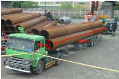
基樁管照片（長19.5公尺、直徑80公分、管厚1.6公分、重量約6公噸）
