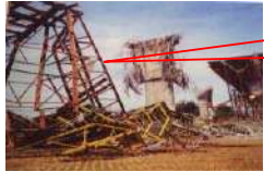
倒塌災害案例：中二高竹南西湖段第C306標後龍高架橋模板支撐倒塌18人輕重傷
