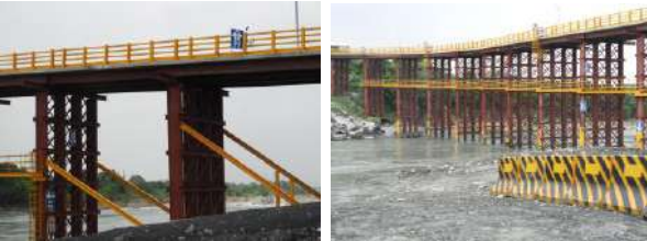
電子圍籬即時監控辨識 工區安全作業警示
