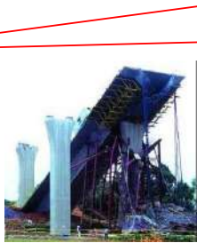
倒塌災害案例：中二高竹南西湖段第C306標後龍高架橋模板支撐倒塌18人輕重傷
