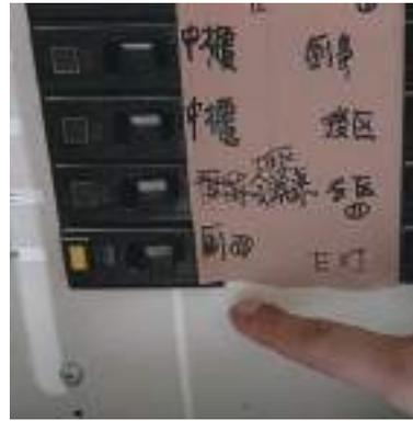
圖 8-8 確認漏電斷路器再開啟狀態
