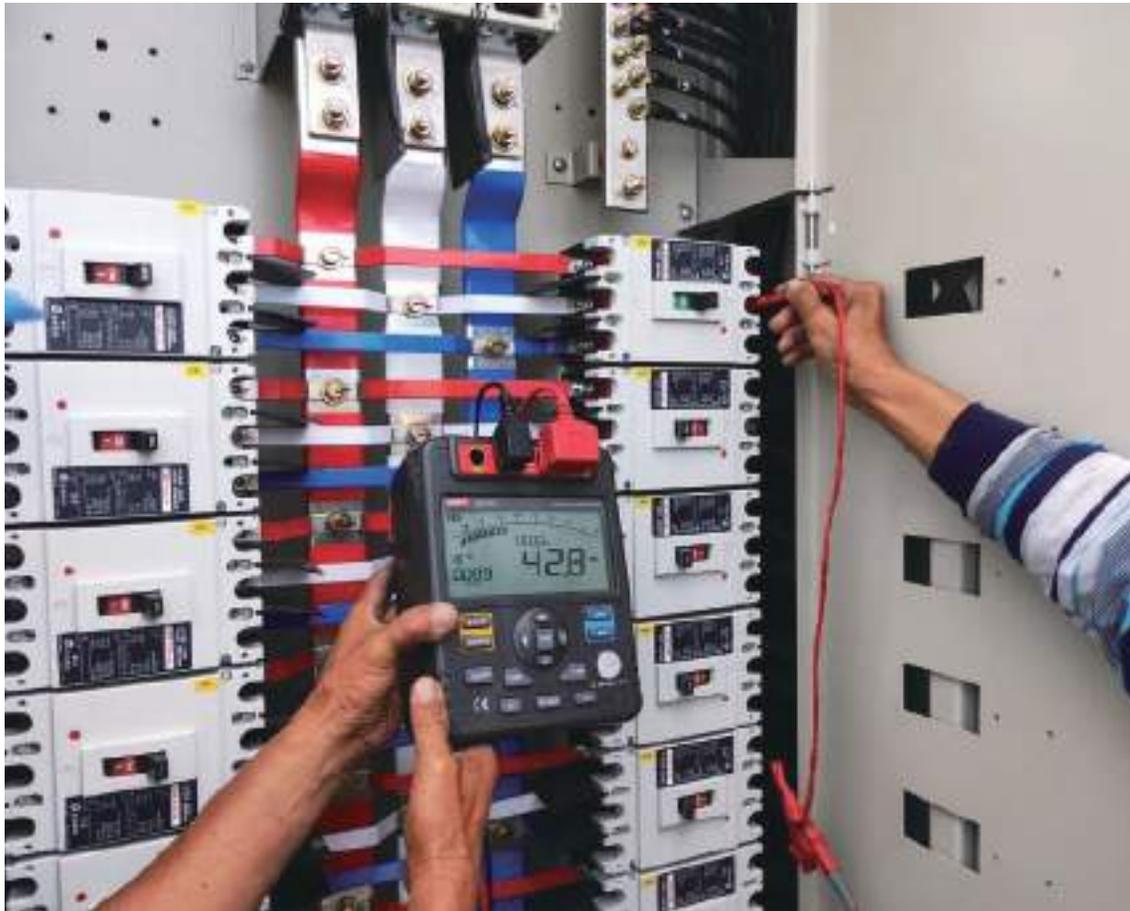
圖 8-16 絕緣電阻測試
