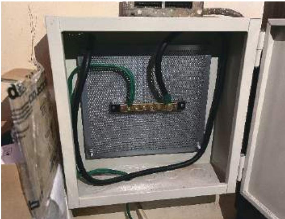
圖 8-12 電器開關箱內之系統接地端子／圖片來源：勞動部職業安全衛生署
