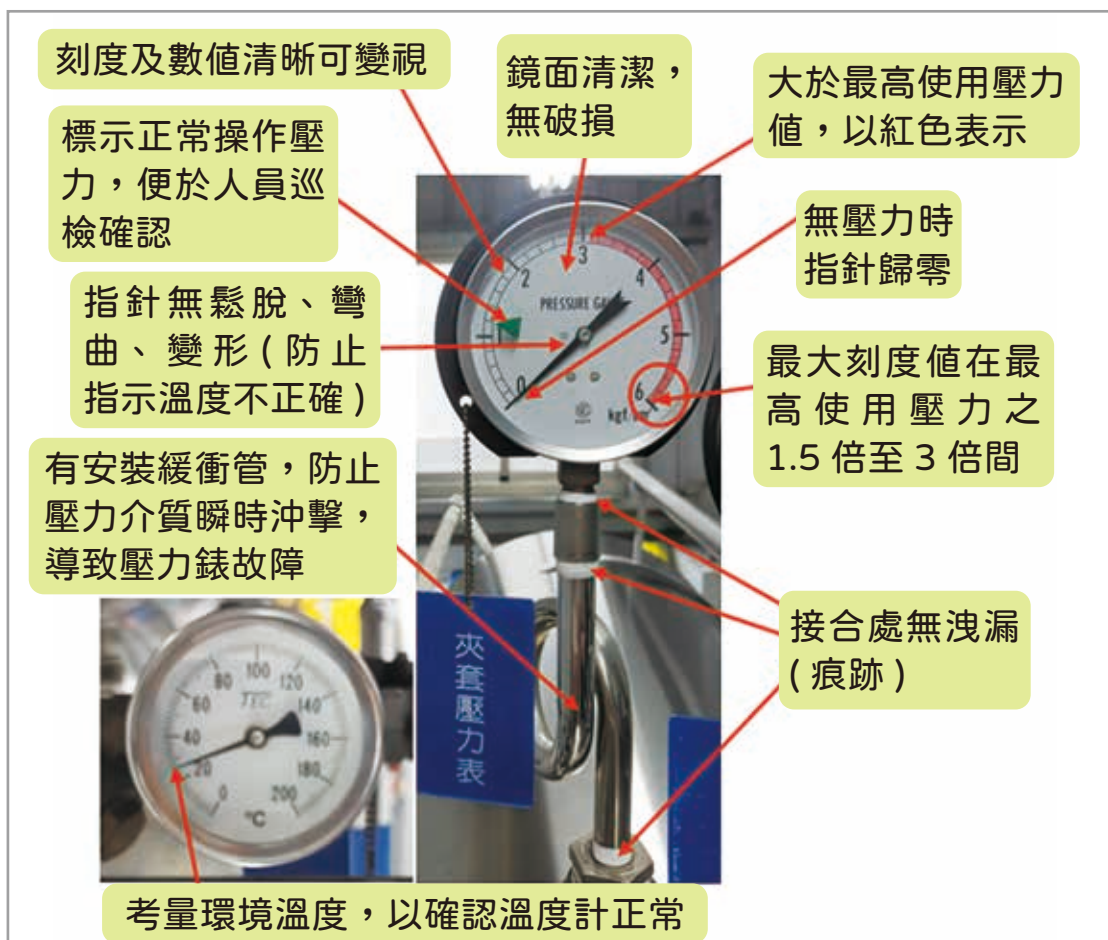
圖 34 溫度、壓力表檢查
