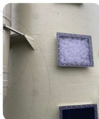
圖4、填充層拉西環，填充高度1.2公尺
