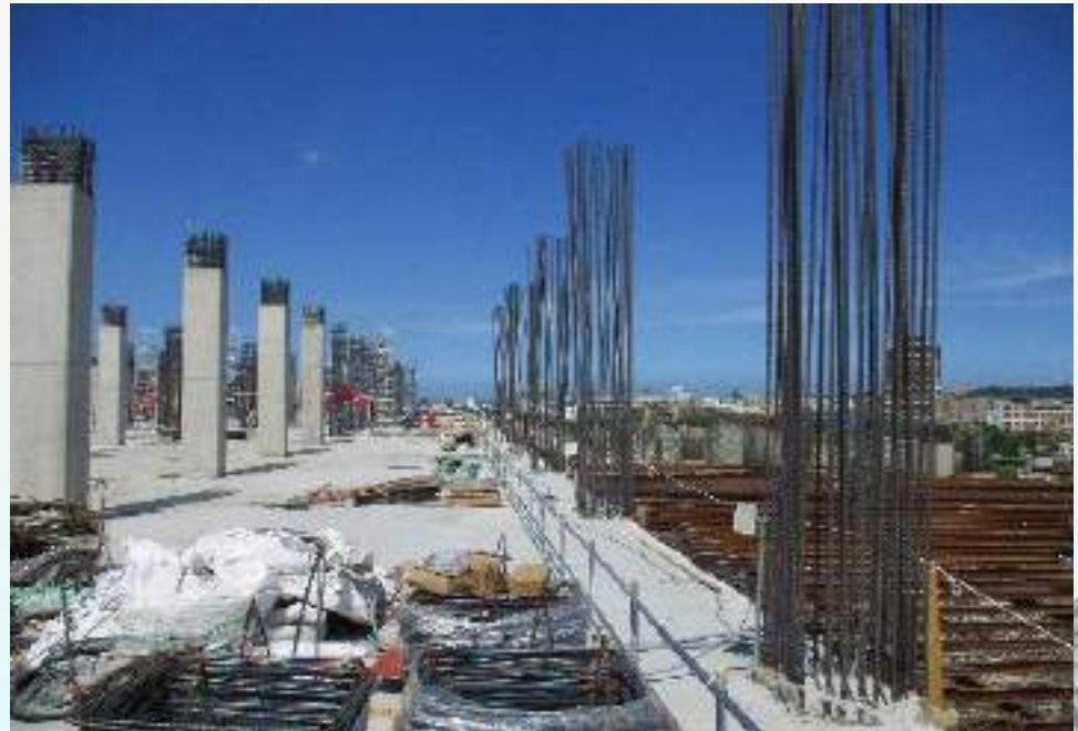
退鄰邊1.5米設置護欄完成，並保留安全母索工人於鄰邊作業勾掛
