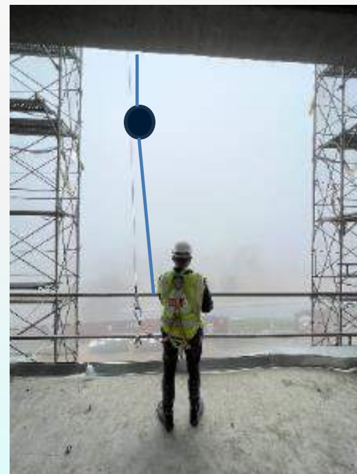
已經調整捲揚式防墜器固定點高度
