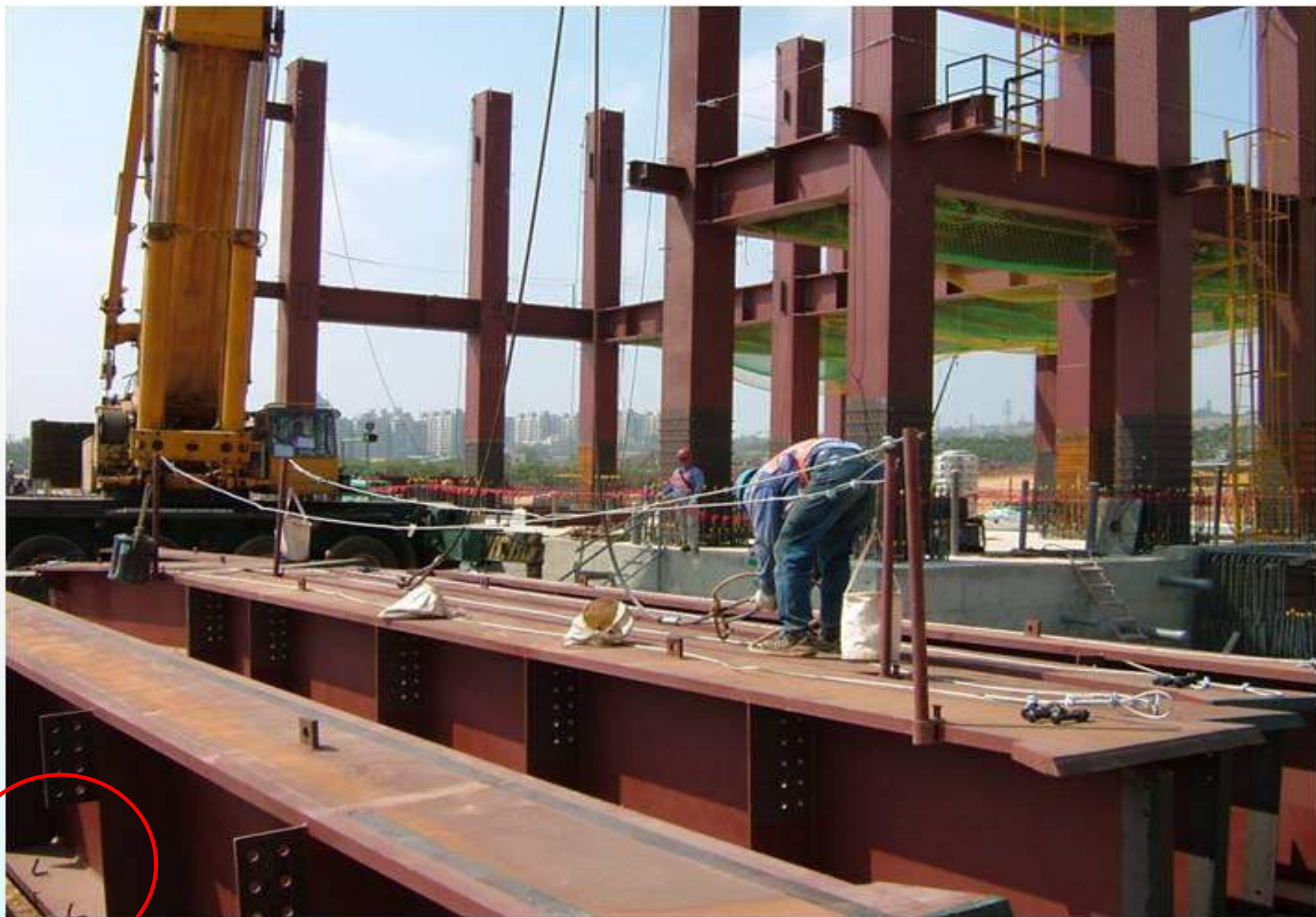
大樑小樑吊裝前地面先行設置立柱（C型夾）及水平安全母索
