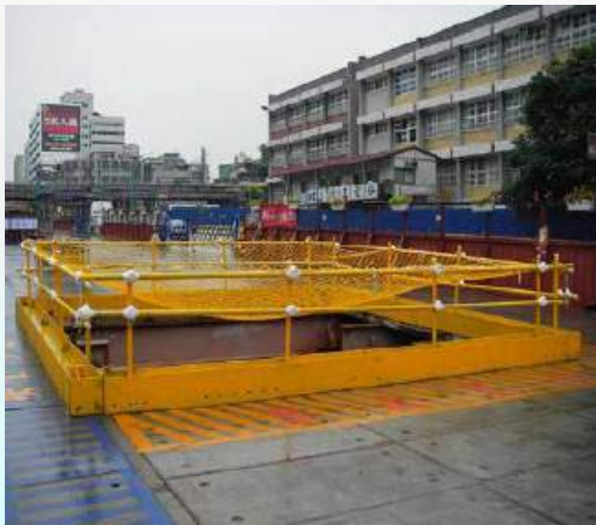
圖 護欄形狀應具上欄杆、中欄杆、腳趾版及杆柱、標示
