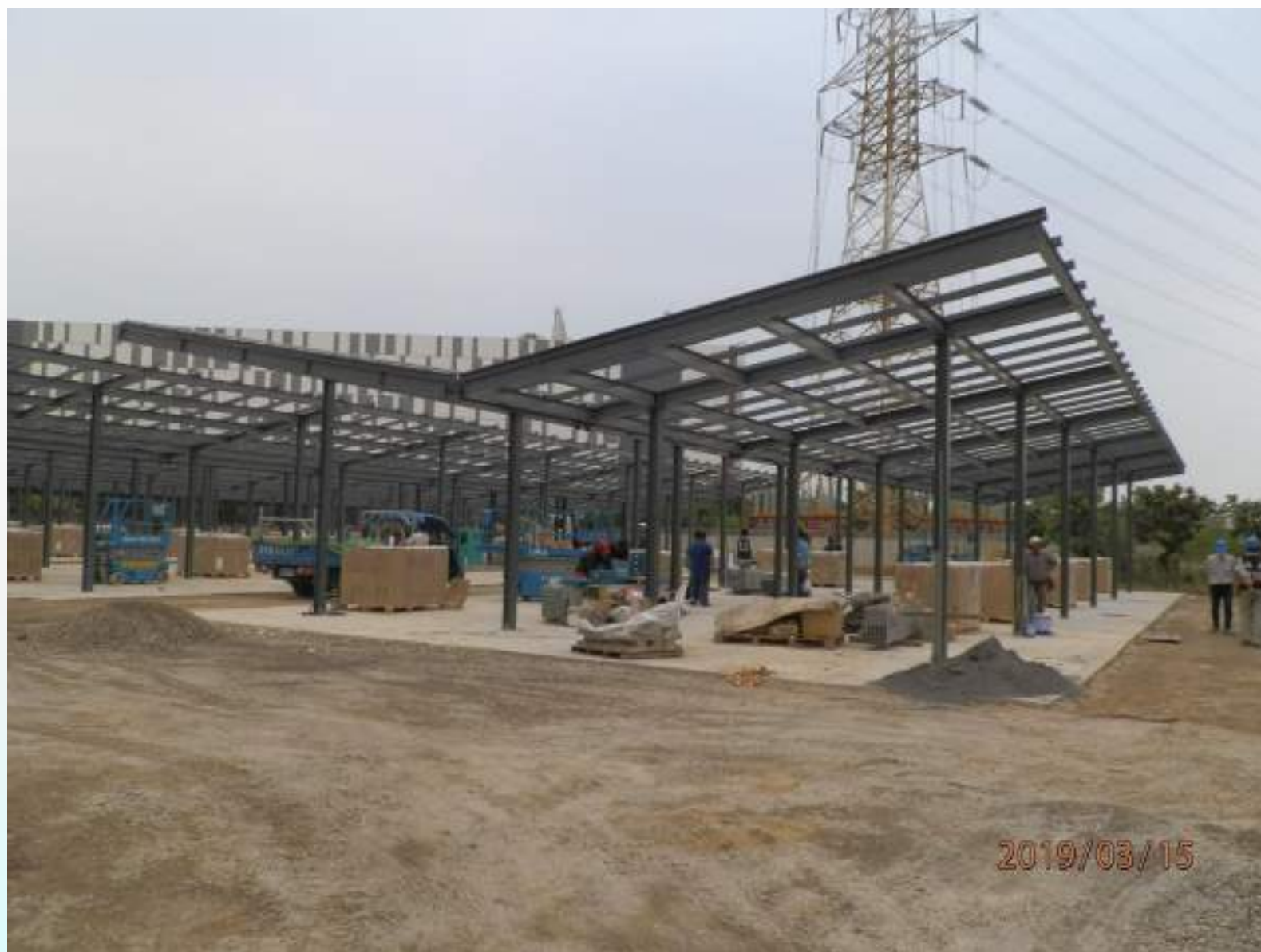
台積電停車場太陽能板施工
