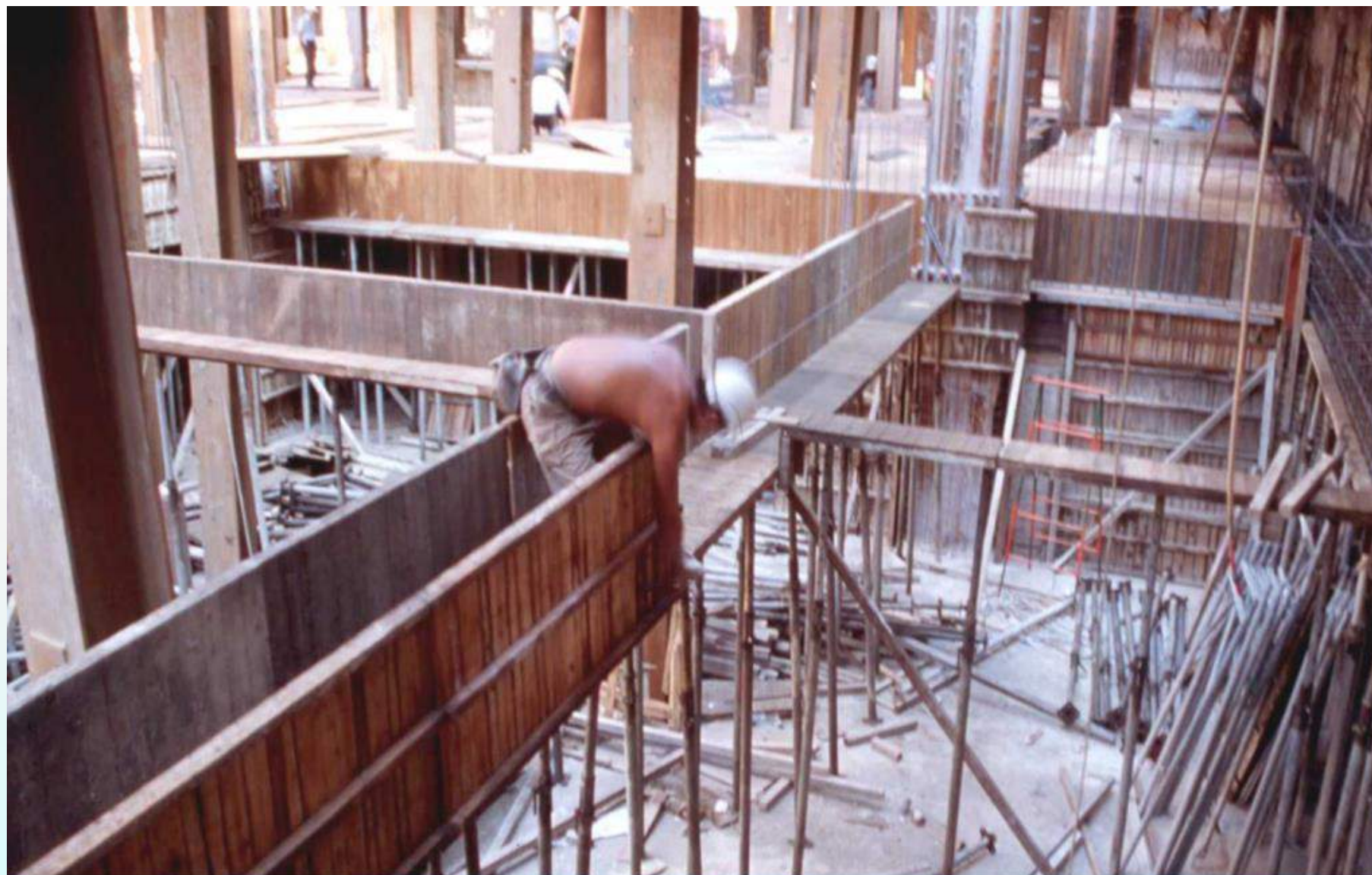
樓版及柱樑底模組立
