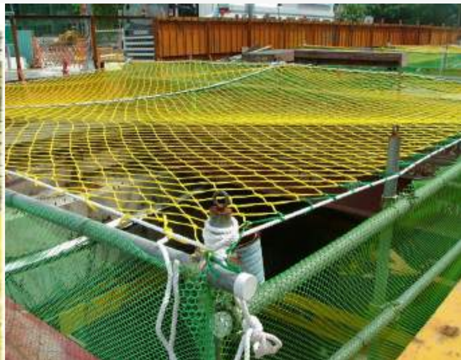
圖 覆網、安全網設置例
