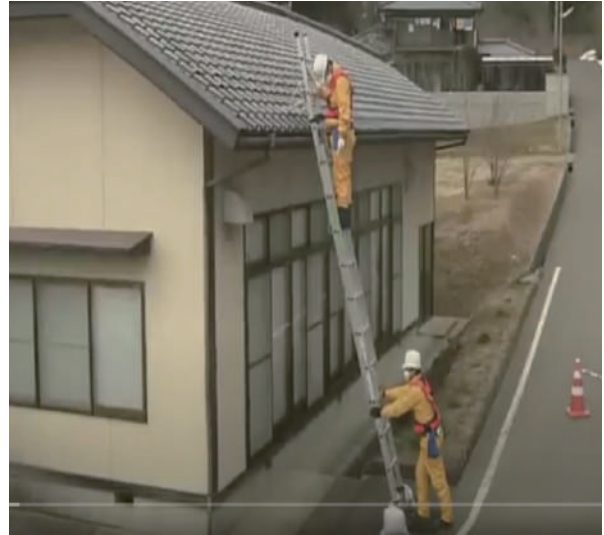
人員上下移動梯時，需夥同作業 並以腳踩住梯角，雙手扶住移動梯
