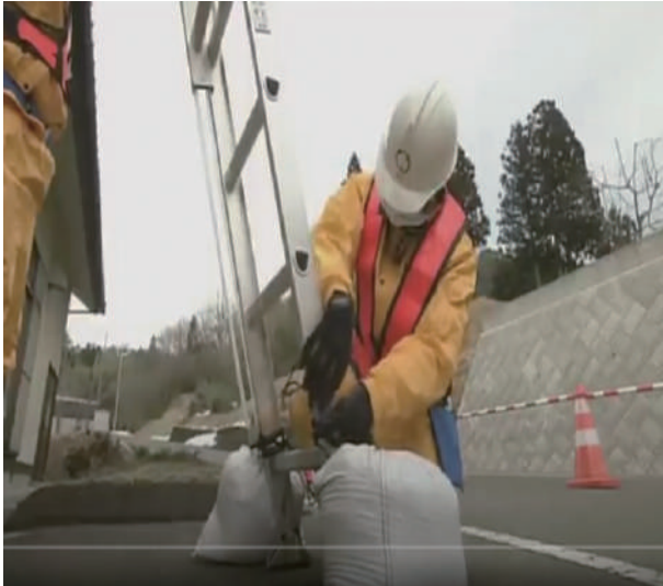
在移動梯旁以75公斤砂包做為配重 預防移動梯左右移動
