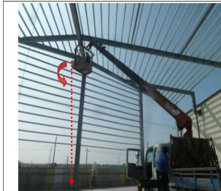
說明二 工作台晃動及傾斜，致罹災者從上欄杆邊緣向後仰而摔出工作台外。
