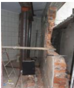
災害現場磚牆拆除作業所搭設簡易工作架
