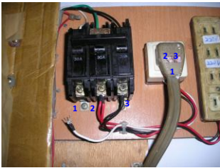
窗型冷氣之電源插頭、無熔絲開關及電源插座
