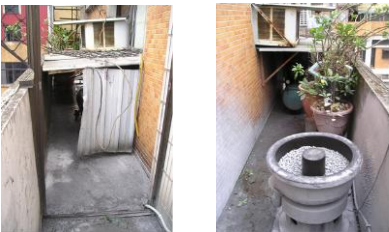
六樓陽台排除積水感電
