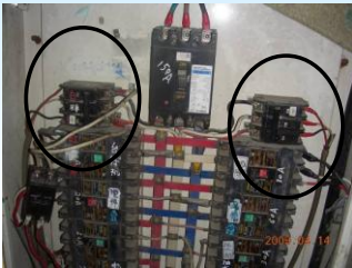
臨時分電盤用電線路跳接
