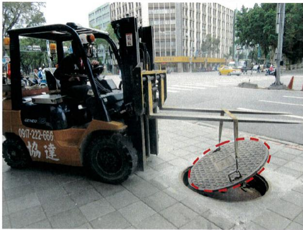
說明一 災害發生人孔，蓋外徑 1090mm，重量約為 200kg
