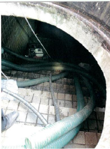
說明四 汽油式抽水馬達擺放於距路面約 2 公尺深處
