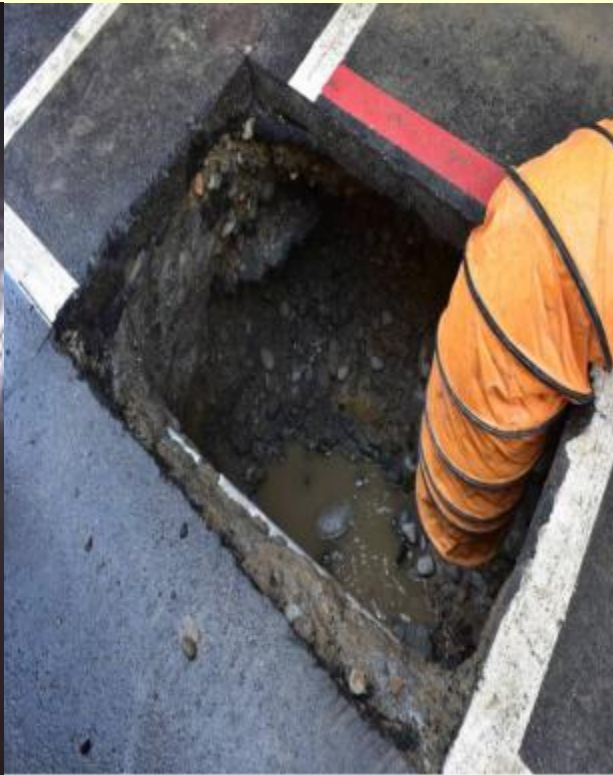
裝設瓦斯管之坑井
