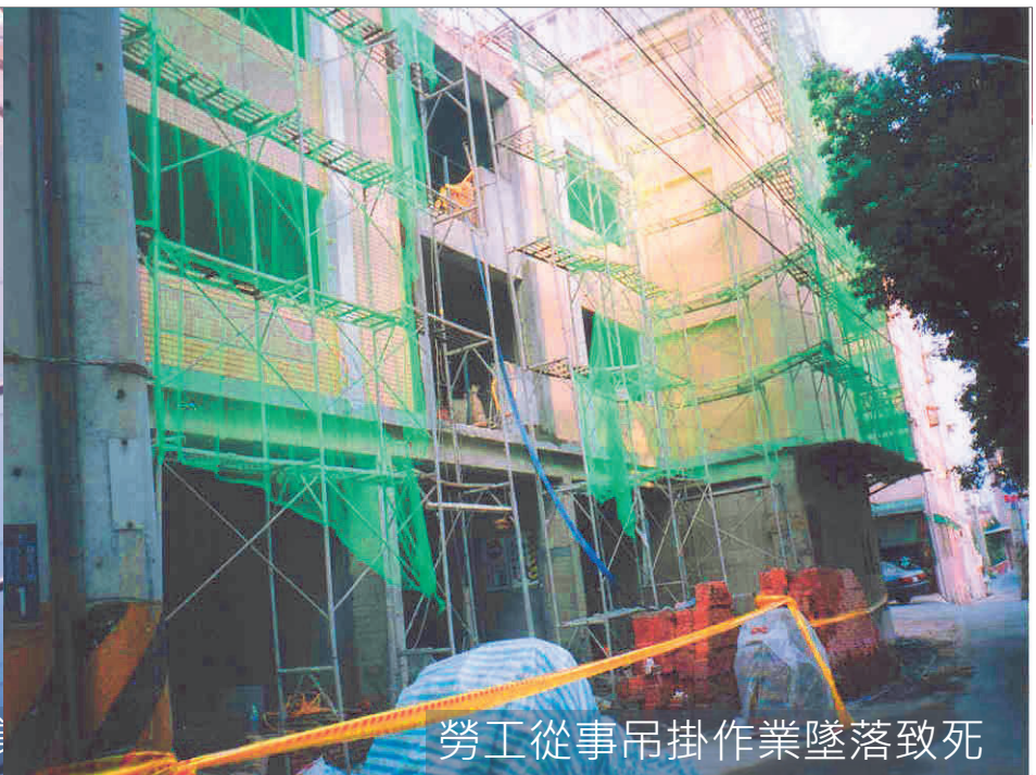
勞工從事吊掛作業
