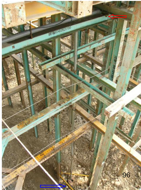
紅箭頭處為罹災勞工所遺留之安全帶，藍箭頭處為罹災勞工墜落後遺留現場之安全帽，墜落高度15.9公尺。
