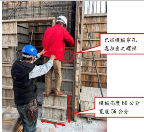
災害發生時，罹災者於地面上放置一塊模板斜靠在已組好之電梯牆模板上，站上該斜靠之模板上緣，並將右手伸進已組立好三塊電梯牆模板內，將放置於已綁紮好電梯牆鋼筋上之螺桿由第三塊模板穿孔處拉出。
