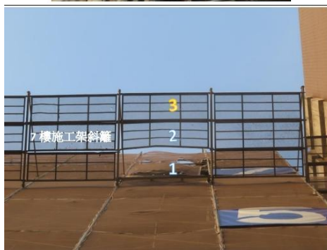
罹災者自高度28.8公尺之8樓外牆施工架外側開口墜落後，經撞擊7樓處施工架編號2斜籬再由編號1斜籬開口墜落至地面致死
