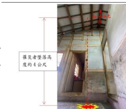
災害發生時，屋頂屋架下方未裝設堅固格柵或安全網等防墜設施，墜落高度約4公尺。
