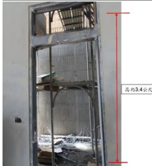
外牆施工架第2層工作臺，高度約3.4公尺
