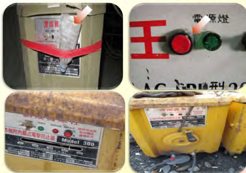
以異物(牙籤、寶特瓶) 恆壓測試鈕造成防電擊裝置失效
